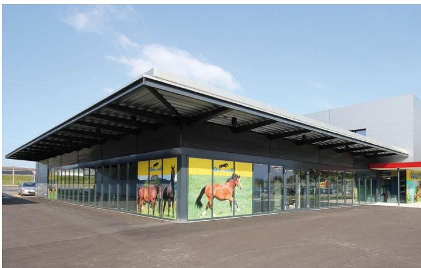
Enfin la réfection des portiques d'entrée, alors que le centre continuait à accueillir ses clients n'a pas été simple. Il a fallu tout d'abord couler des jambages de béton obliques, de 7 mètres de haut, avec une précision millimétrique, puis poser sur ces éléments 2 poutres préfabriquées et précontraintes de 18 mètres par 2.50 mètres et épaisses de 70 centimètres pesant 60 tonnes chacune.
