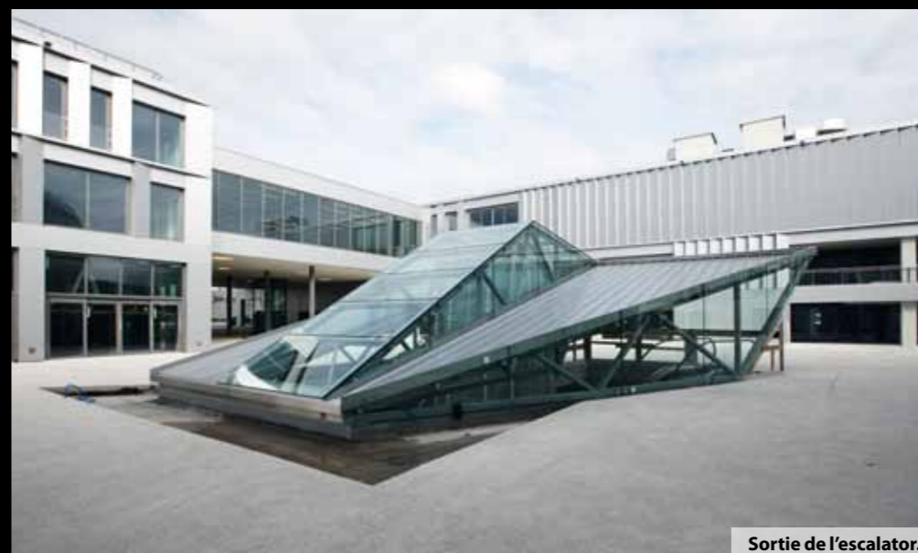
Sortie de l'escalator.
